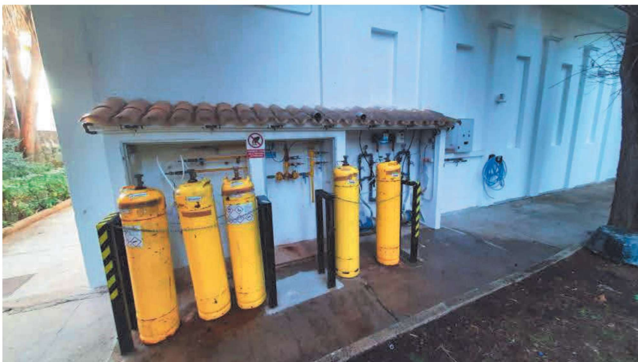
Figura 5. Instalación de cloración.
